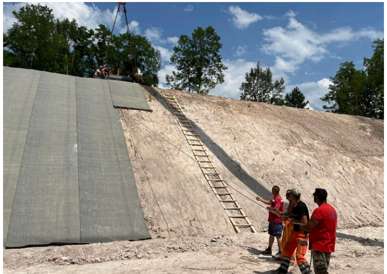
CCX-M ® terítése-lehúzása a rézsűn függőleges irányba
