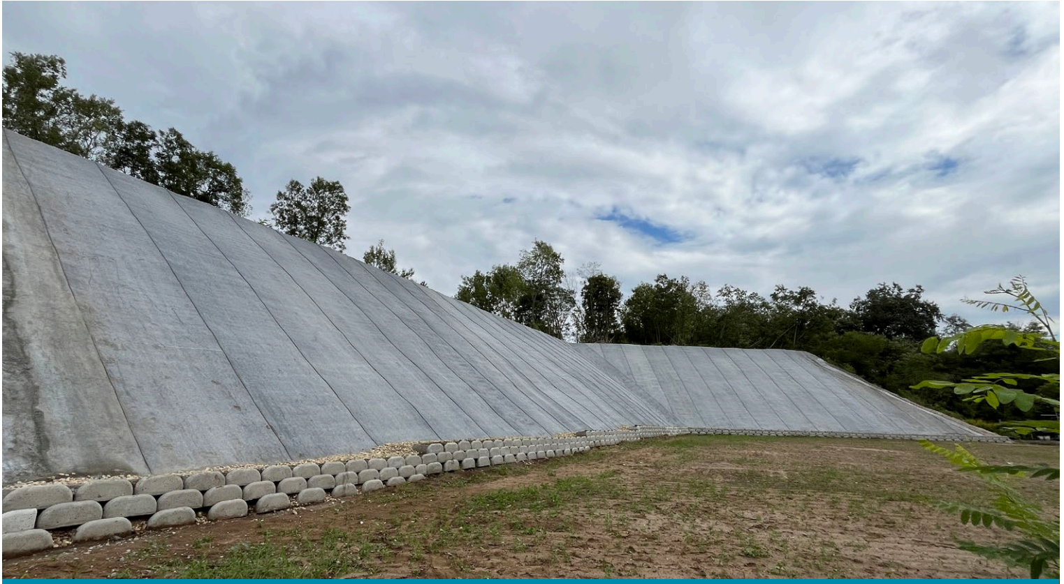
Az elkészült CCX-M™ rézsűvédelem
