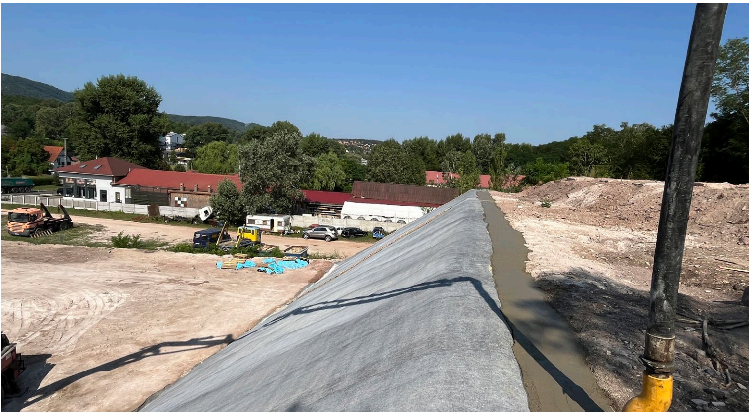
Helyszíni betonnal kiöntött leterhelő árkok
