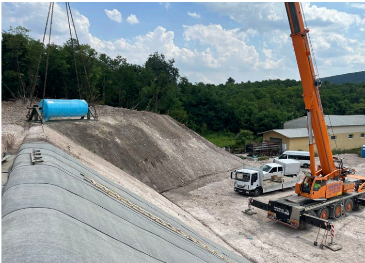
Egyedi gyártású tekercestartó bakra helyezett CCX-M ® tekerces daruzása
