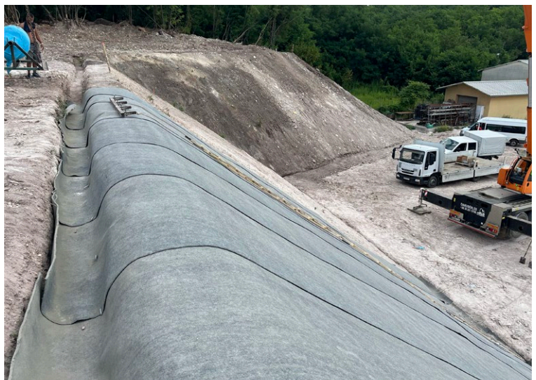
A leterhelő árkokban J-kampókkal rögzített CCX-M ®
